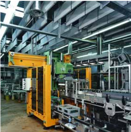
Figure 81: plafond acoustique dans une halle de remplissage de bouteilles. Les panneaux acoustiques utilisés («baffles») sont en fibres minérales.
