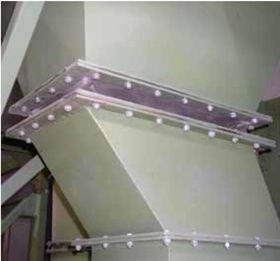
Figure 69: joints en matière synthétique pour la conduite d'évacuation de l'air d'une unité de fabrication.
