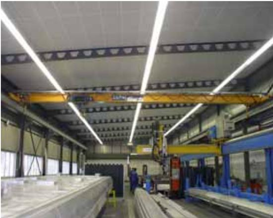
Figure 80: plafond acoustique dans un atelier de soudage d'aluminium.
